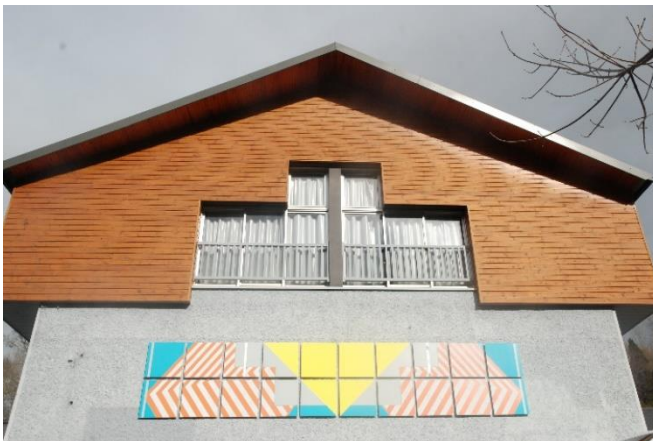
Polyptique du tympan - 2020/21- Façade du collège de Tardets (64), Commande du département des Pyrénées-Atlantiques L'art dans l'espace public
